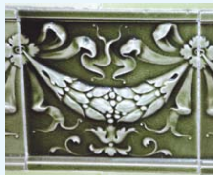
Zabytkowe, ceramiczne kafle znajdujące się w sklepie mięsnym
